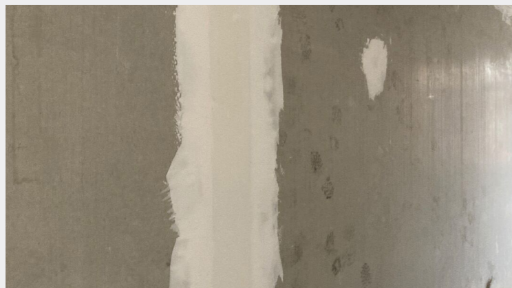
Afwerking van prefab betonwanden.
