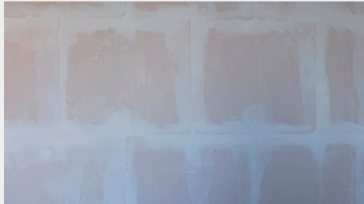
Behangklare afwerking van de gipsblokken.
