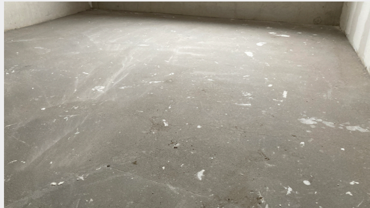
Afwerkloer van zandcement.
